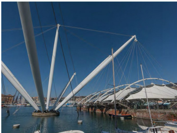
Il Porto Antico di Genova è stato riqualificato da Renzo Piano ed è diventato un'attrazione non solo per i turisti, ma anche per i genovesi. Tra le opere più significative, al suo interno, la Biosfera, l'isola delle chiatte, la Piazza delle feste e il Bigo (in foto).
